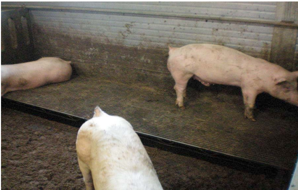
Fig. 3: De opening tussen de betonvloer en het verhoogde metalen rooster waardoor het strooiselmest in het mestkanaal terecht komt (foto Wageningen UR Livestock Research). Door extra afschot van de betonvloer bij het mestkanaal wordt strooiselmest sneller afgevoerd.
