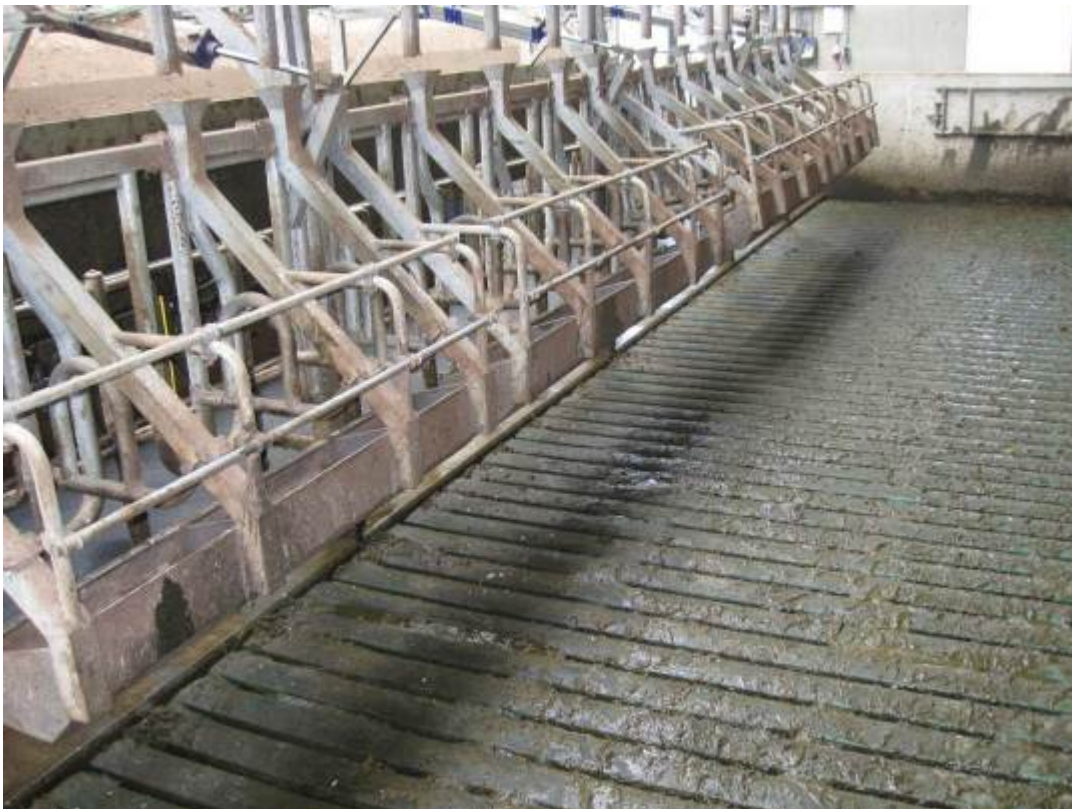
Uitloop rapid exit, deze ruimte is alleen in gebruik tijdens het melken
