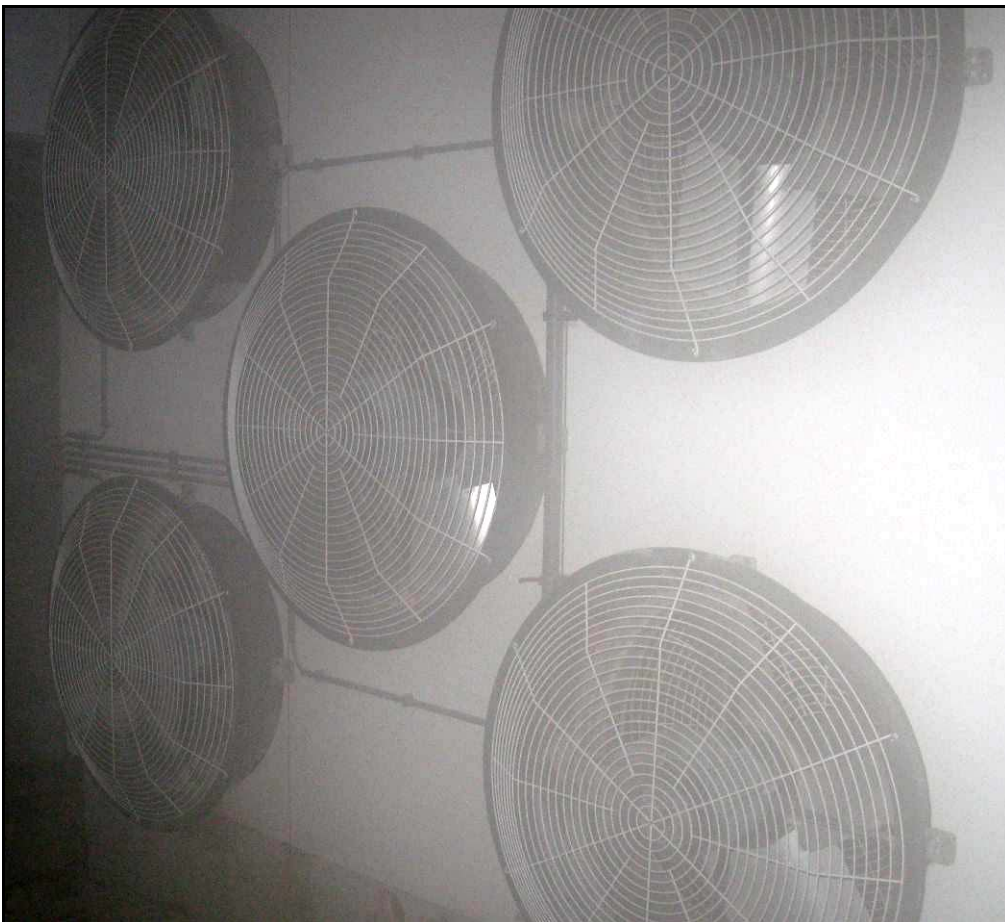
Ventilatoren (drukkamer vóór de wasser)
