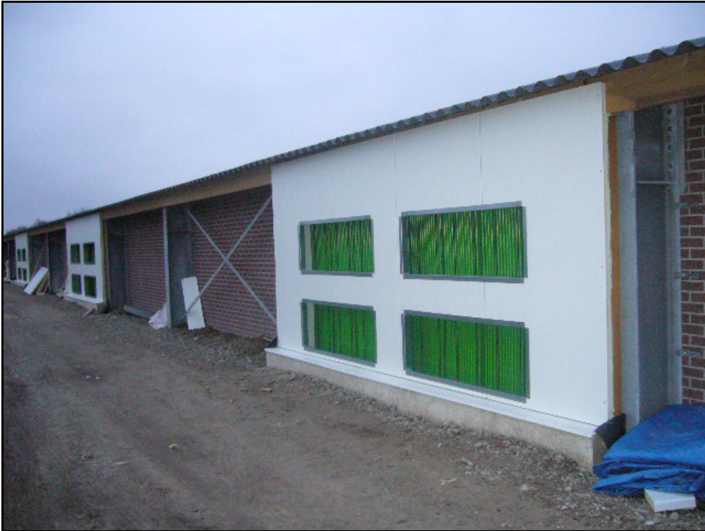
Luchtinlaat met warmtewisselaar (LC-units)
