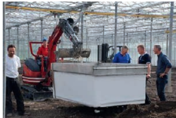
Voor het verder afwerken wordt een lektest gedaan.
