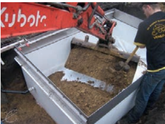
Tenslotte wordt de lysimeter laag voor laag afgevuld.
