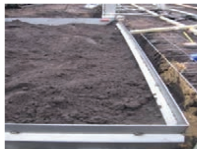
Voor het verder afwerken wordt een lektest gedaan.
