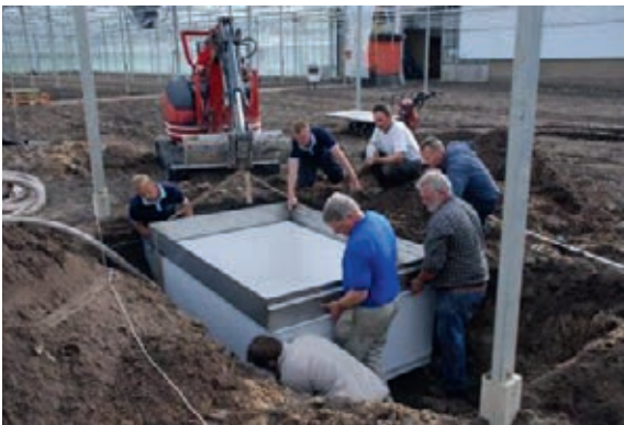
De grond wordt laag voor laag apart weggezet.
