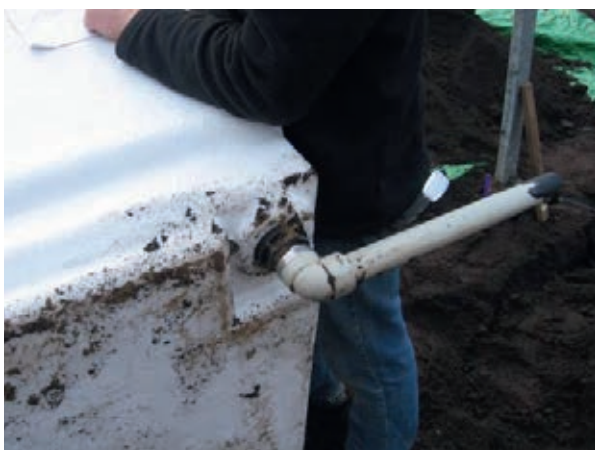
Afvoer onderzijde lysimeter: water- en stofdicht gemonteerd.
