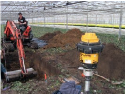
De bak moet waterpas worden geplaatst.
