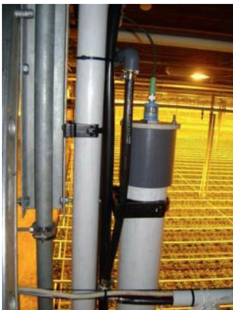
Ultrasone sensor voor meting waterhoogte drainwater.
