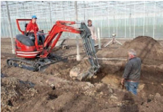
Uitgraven van het gat voor de lysimeter.
