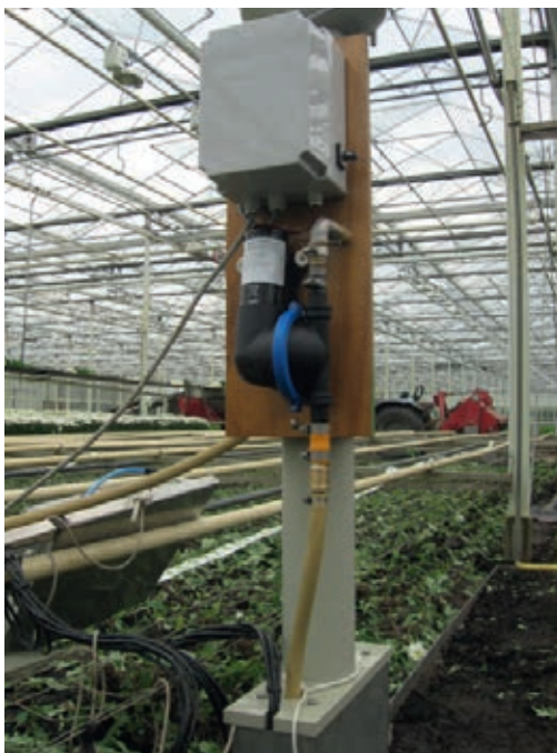
Plaatsing drainkoker, situatie bij de biologische bedrijven, waar twee parallelle bakken zijn geplaatst.
