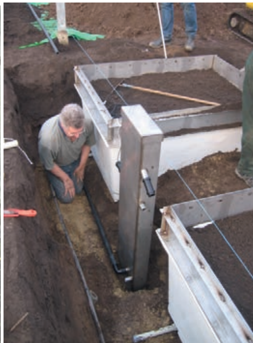
Stoomafzuigventilator, geplaatst op de drain afvoerkoker geïntegreerd met pomp voor afzuigen drainwater.
