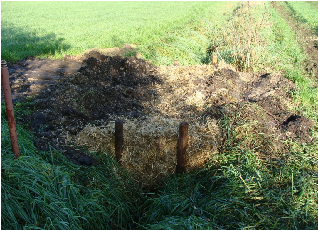
Foto 2. Uitgegraven sloot waarin de strobaal is geplaatst (boven) en de gestabiliseerd geplaatste strobaal (onder)
