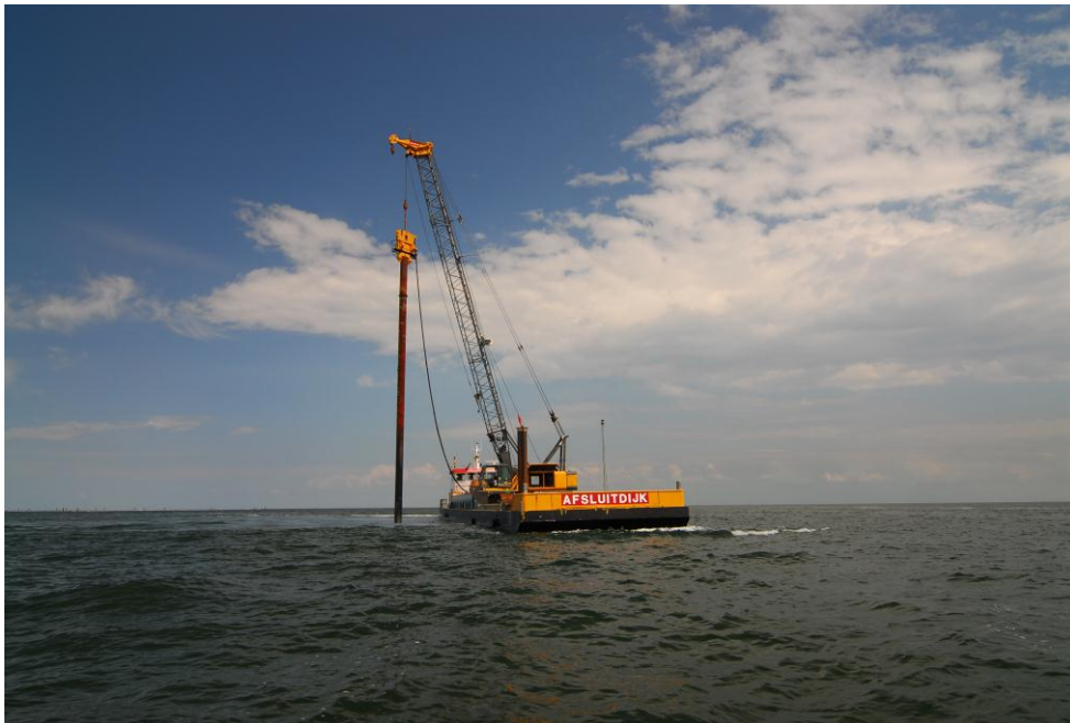
Figuur 10 Werkschip "Afsluitdijk" fa. Klein Wieringen tijdens het positioneren van het 20 m-paalanker.
