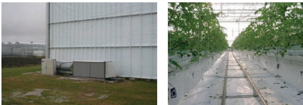
Figuur 2. Links: De luchtbehandelingskast buiten de kas om lucht aan te zuigen voor gecontroleerde ventilatie. In de luchtbehandelingskast zit een ventilator en een warmtewisselaar. Rechts: De luchtverdeelslangen onder de goot.
