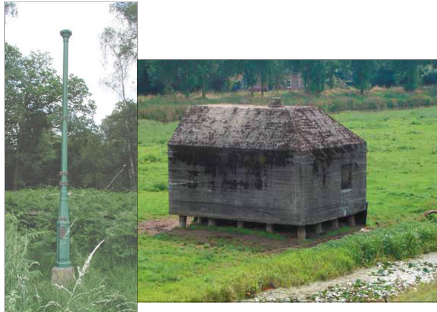
Figuur 18: Voorbeelden van bodemdaling in veengebieden. Links: de top van de paal geeft het maaiveldniveau van een veenweidegebied in Groot-Brittannië in 1848; Rechts: door bodemdaling ten gevolge van inklinking van het veen zijn de fundamente van deze bunker uit 1940 in het Nederlandse veenweidegebied bloot komen te liggen.
