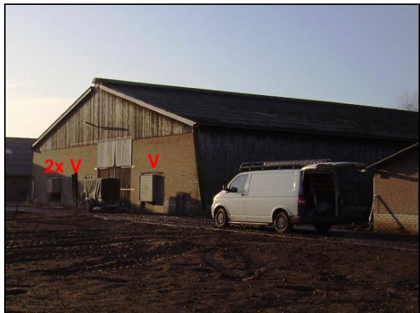
Achterzijde van de proefstal met twee kleine ventilatoren links en één grote rechts
