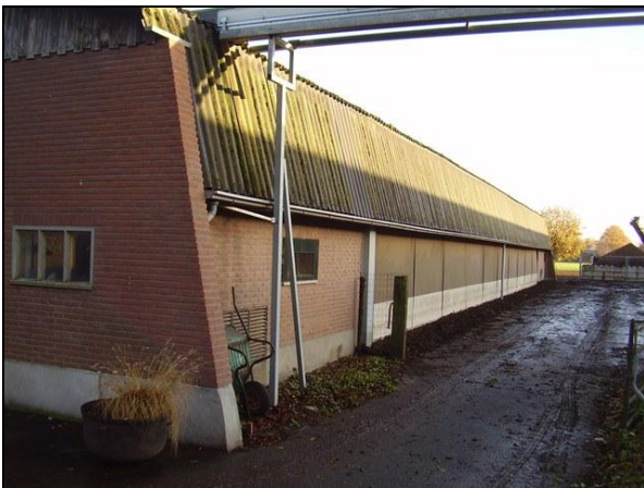
Rechterzijde van de proefstal, met gesloten windbreekgaas gordijn van de uitloop
