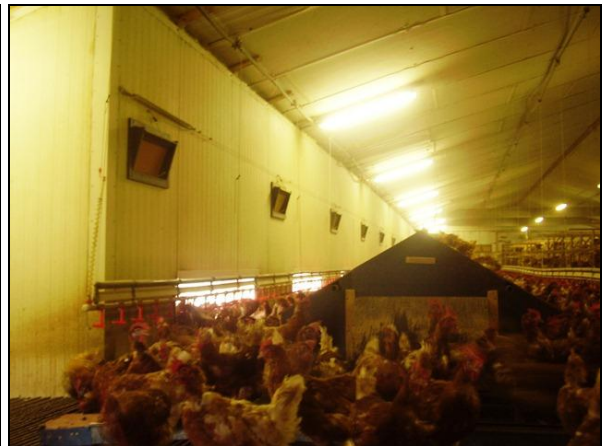
Binnenaanzicht op de rechter zijgevel (met inlaatventielen en uitloopopeningen) en de beun (met rij legnesten en drinklijnen)
