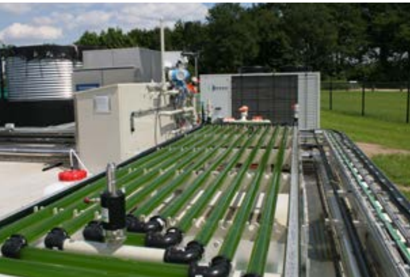
Horizontale buisreactor links en de gestapelde versie, rechts
