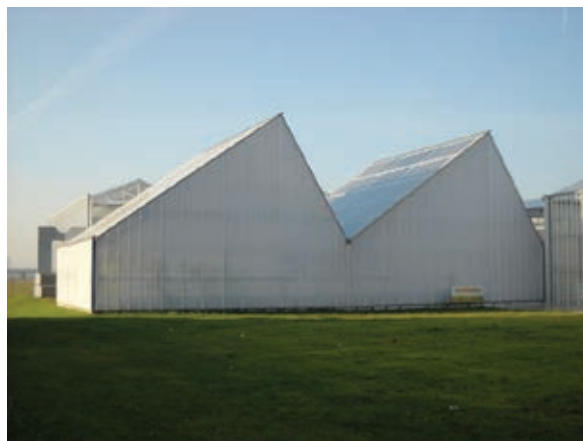
Daglichtkas in Bleiswijk met een systeem om geconcentreerd warmte in te vangen, door toepassing van Fresnel platen.
