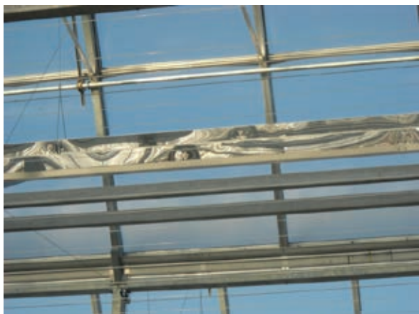
Daglichtkas in Bleiswijk met een systeem om geconcentreerd warmte in te vangen, door toepassing van Fresnel platen.
