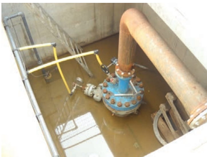
Warmteput (diepe geothermie) bij gebr. Duijvestein uit Pijnacker (links), en voor ondiepe geothermie en Warmte-Koude Opslag bij van Gellecum uit Bommel (rechts).
