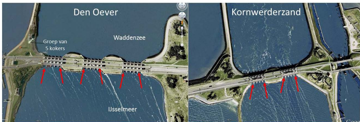
Figuur 3-2 Kaartjes met de spuicomplexen bij Den Oever en Kornwerderzand. Den Oever heeft drie groepen van vijf spuikokers en Kornwerderzand heeft twee groepen van vijf spuikokers. Bij de buitenste schuiven van elke groep van spuikokers (rode pijlen) kan aangepast spuibeheer worden toegepast, waarbij de schuiven op een 'kier' worden gezet. Een kier wordt gecreëerd doordat de schuiven maar gedeeltelijke worden opengezet en er ruimte ontstaat tussen de onderkant van de schuif en de bodem.
