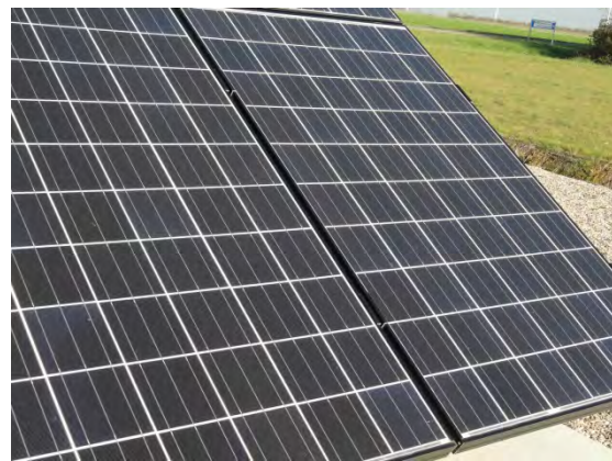
Foto 2: polykristallijn silicium panelen Kyocera
