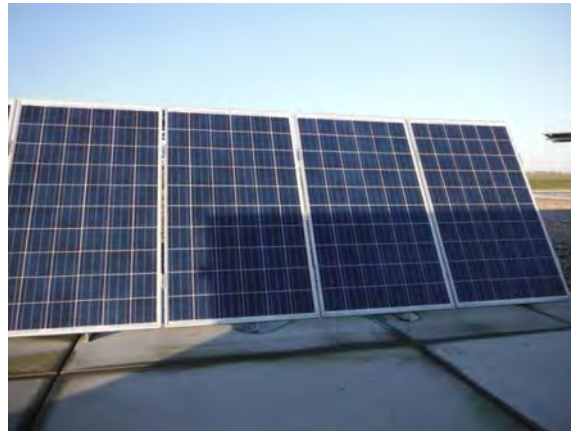
Foto 11: Schaduw van 1 e rij op 2 e rij variabele Solarpark opstelling
