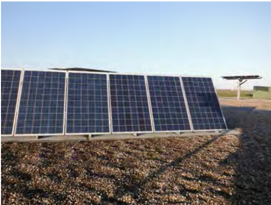
Foto 10: Schaduw van vaste op variabele Solarpark opstelling
