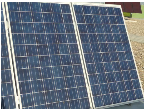
Foto 1: polykristallijn silicium panelen van Solarpark
