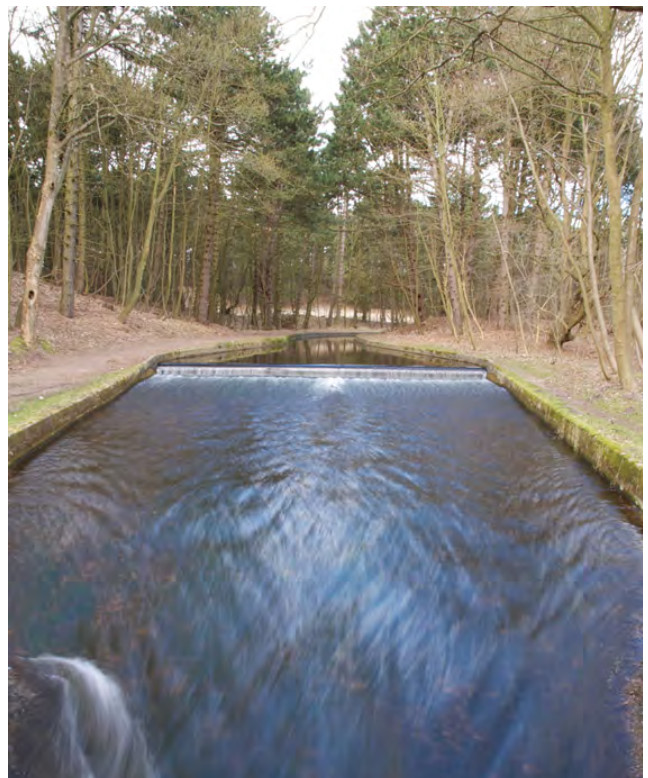
INFILTRATIEKANAAL IN DE AMSTERDAMSE WATERLEIDINGDUINEN NABIJ HAARLEM.
