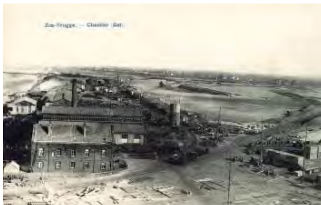
BOUW VAN DE HAVEN IN ZEEBRUGGE ROND DE EEUWWISSELING
