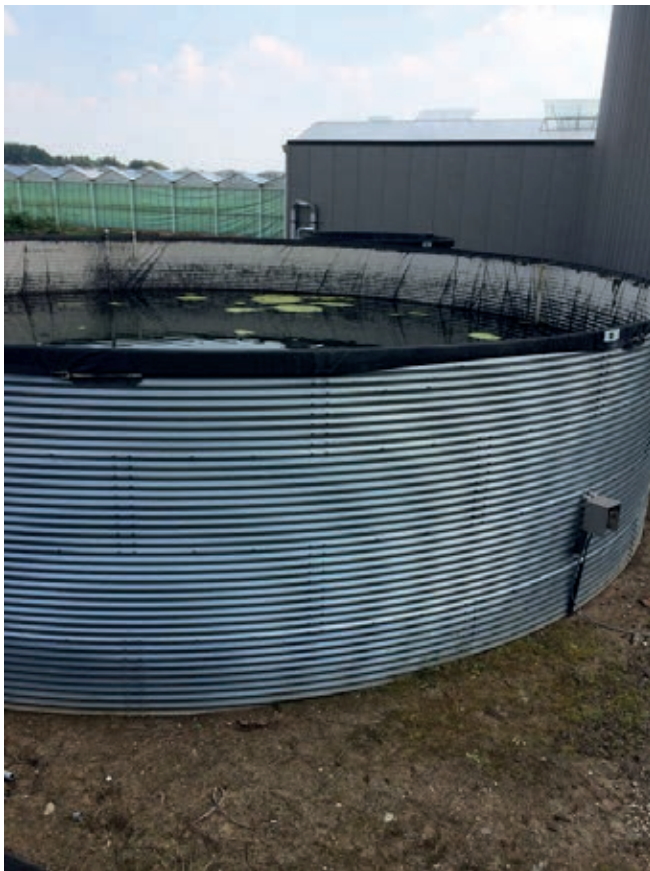
Figuur 13. Silo met drainagewater.
