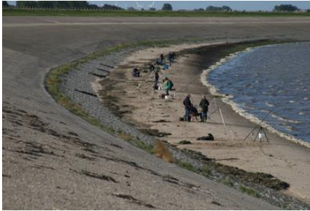
Figuur 5.7 Asfalt bekleding op de Rinkwielsedijk (bij Wieringen)
