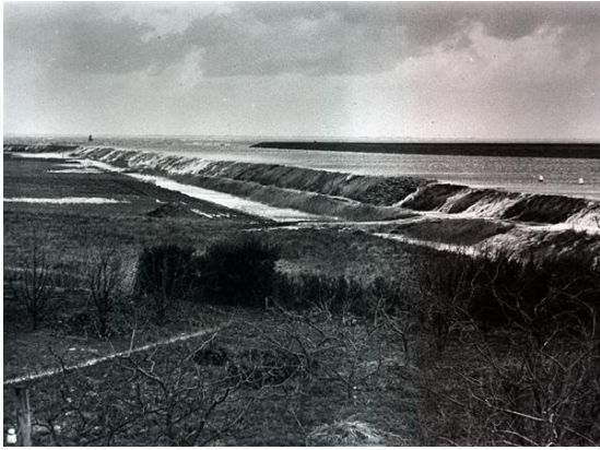
Figuur 5.4 Overloop van de dijk voor het Molengors bij Stellendam (23-12-1954). Bron: https://beeldbank.rws.nl , Rijkswaterstaat.
