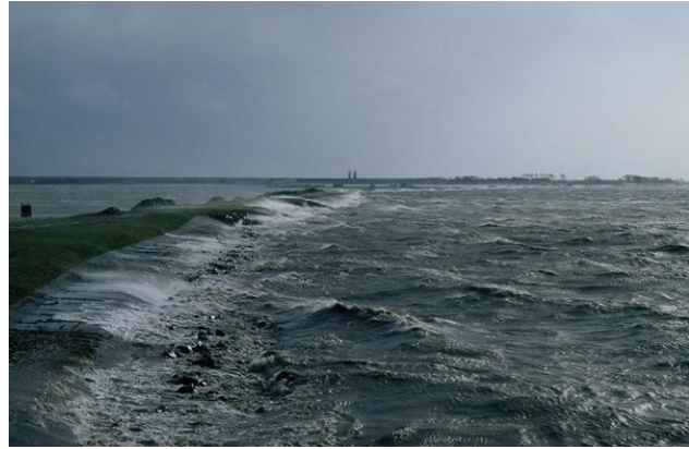
Figuur 5.5 Houtribdijk tijdens storm. Incidentele golfoverslag (26-2-1990). Bron: https://beeldbank.rws.nl , Rijkswaterstaat.
