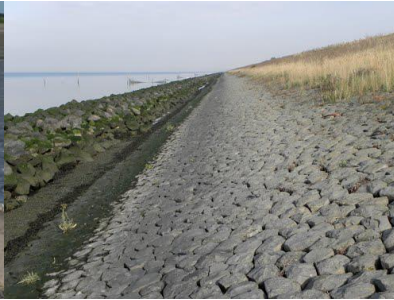
Figuur 5.8 Basaltblokken en stortsteen op de Afsluitdijk
