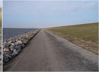
Figuur 5.9 Stortsteen, asfalt en gras op Schiermonnikoog
