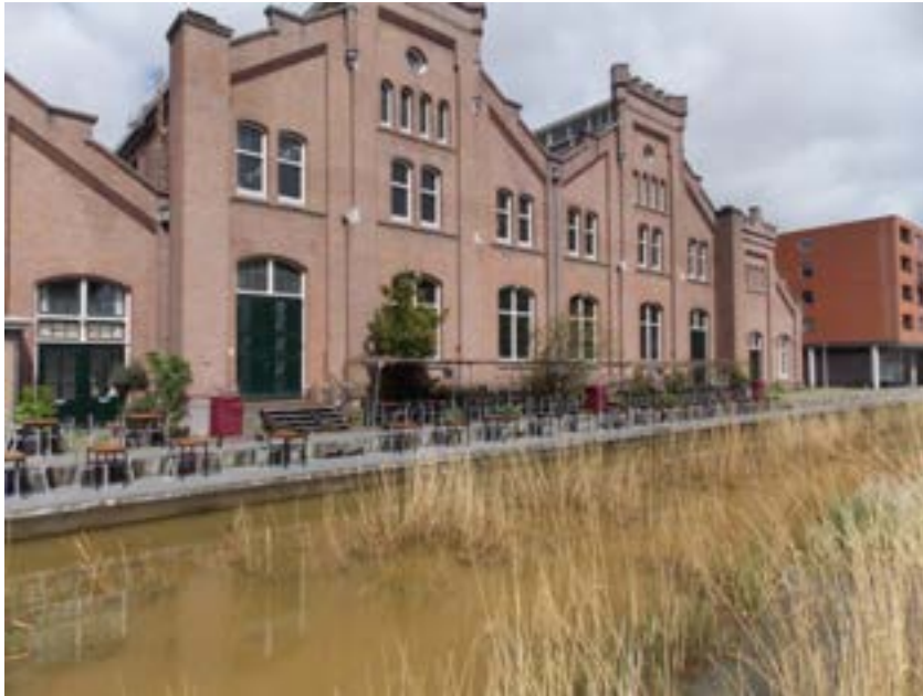
Figuur 12. Foto van de waterleliegracht genomen op 15 april 2014 met op de achtergrond Het monumentale pompgebouw van het GWL-terrein.
