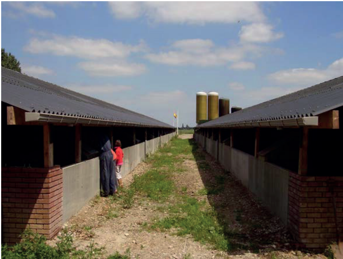
Figuur 2.3. Doorkijk tussen beide stallen met de biobedden tegen de stal aan geplaatst; het dak van de stal loopt door boven de biobedden.
