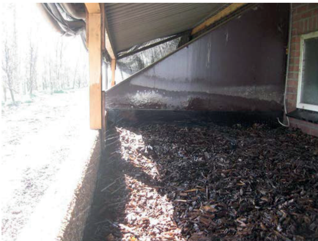
Figuur 2.5. Foto van een deel van een biobedcompartiment, gevuld met houtsnippers; tevens is de zijkant van een van de luchtdoorvoerkanalen te zien (driehoekig paneel) die het biobed in compartimenten delen.
