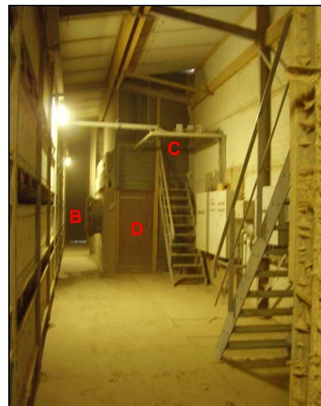
Drukkamer (gang) tussen achterzijde van de stallen en de droogtunnel, gezien vanaf de andere zijde. Zichtbaar zijn de toegangsdeur (B) en deuren van stallen 1 (C) en 2 (D)
