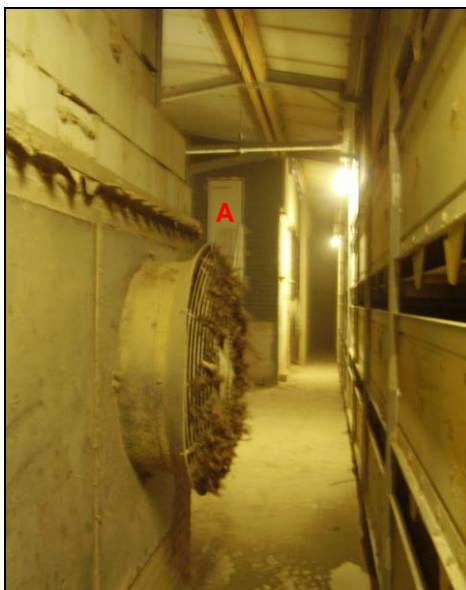
Drukkamer (gang) tussen achterzijde van de stallen en de droogtunnel, gezien vanaf de toegangsdeur. Zichtbaar is de deur van stal 3 (A).
