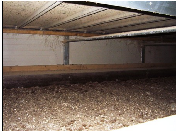
Detailfoto van de droogmest op plaat 3. Zichtbaar is ook de onderzijde van de geperforeerde elementen van plaat 2
