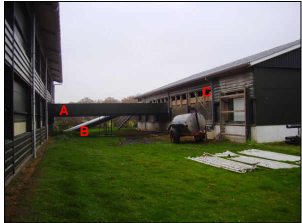
A: luchtkanalen met in totaal 4 drukventilatoren B: kanaal met mestband voor transport van mest vanuit de stal naar de droogtunnel C: Open strook in de zijgevel van de mestopslagloods voor luchtuitleat van drooglucht
