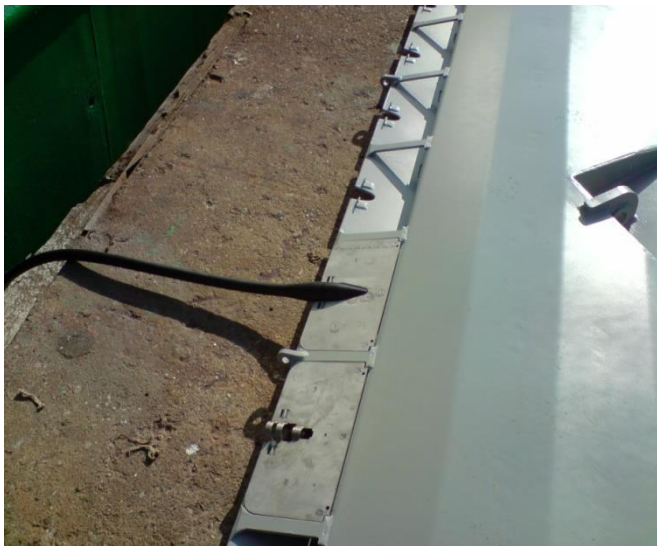
Figuur 2.7 Module geplaatst in cassette van SumWing
