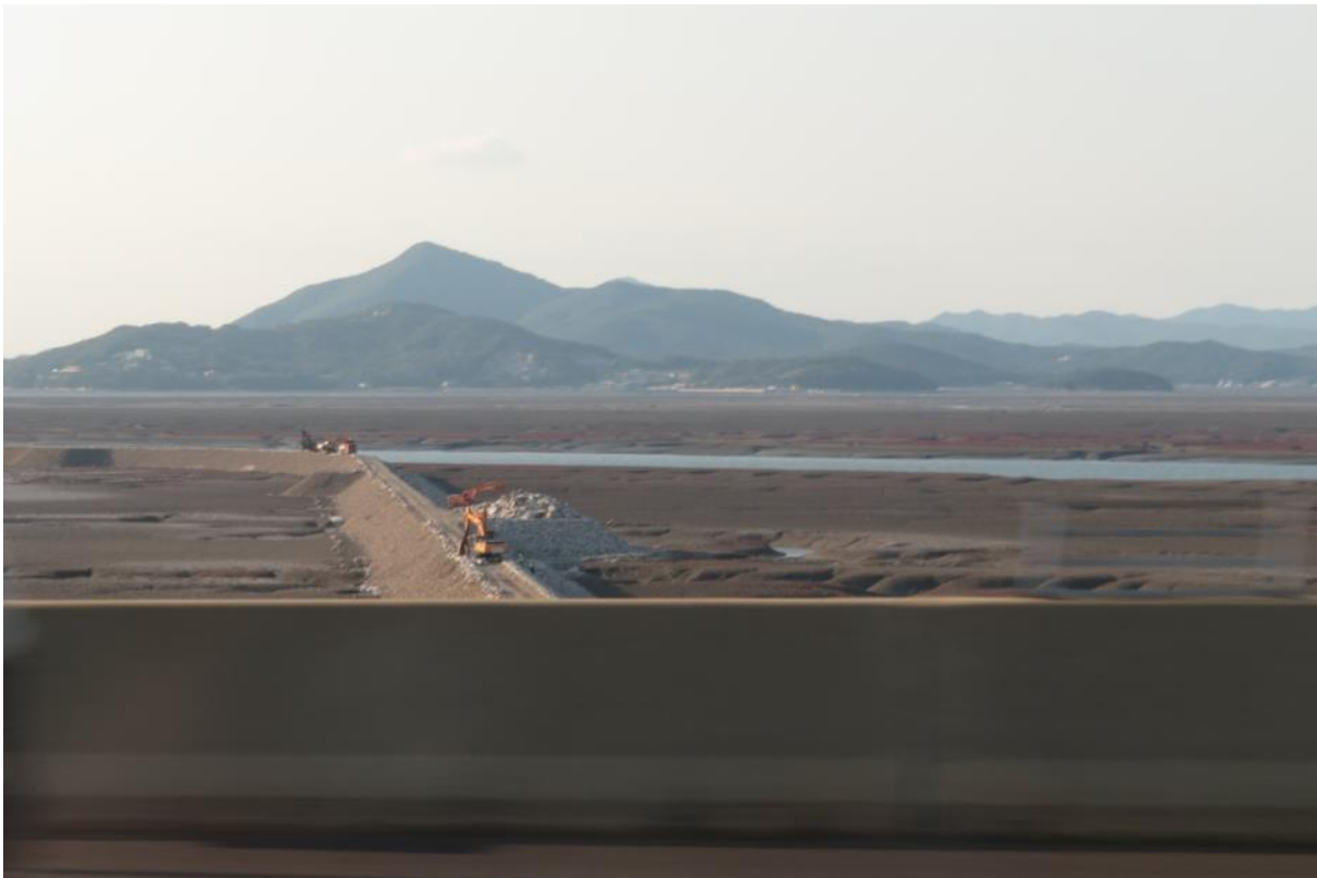
De bouw van dammen in de slikken van de Getbol.
