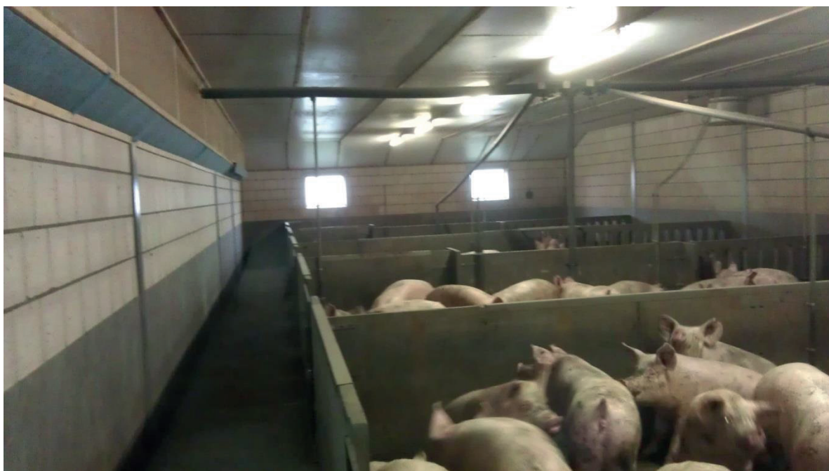
Figuur 1 Afdeling met vleesvarkens op bedrijf 1 met luchtinlaat (links via blauwe filterdoek) en afzuiging (rechts via ventilatiekokers)
