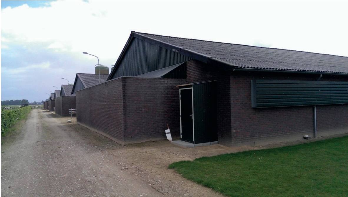
Figuur 6 De vleeskuikenstallen op bedrijf 6 met de bakken rond de ventilatoren in de eindgevel
