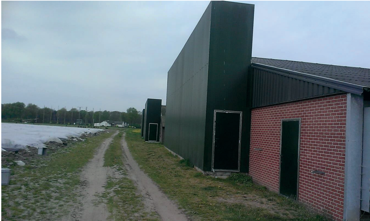
Figuur 7 Drie vleeskuikenstallen op bedrijf 7 met de bakken rond de ventilatoren in de eindgevel
