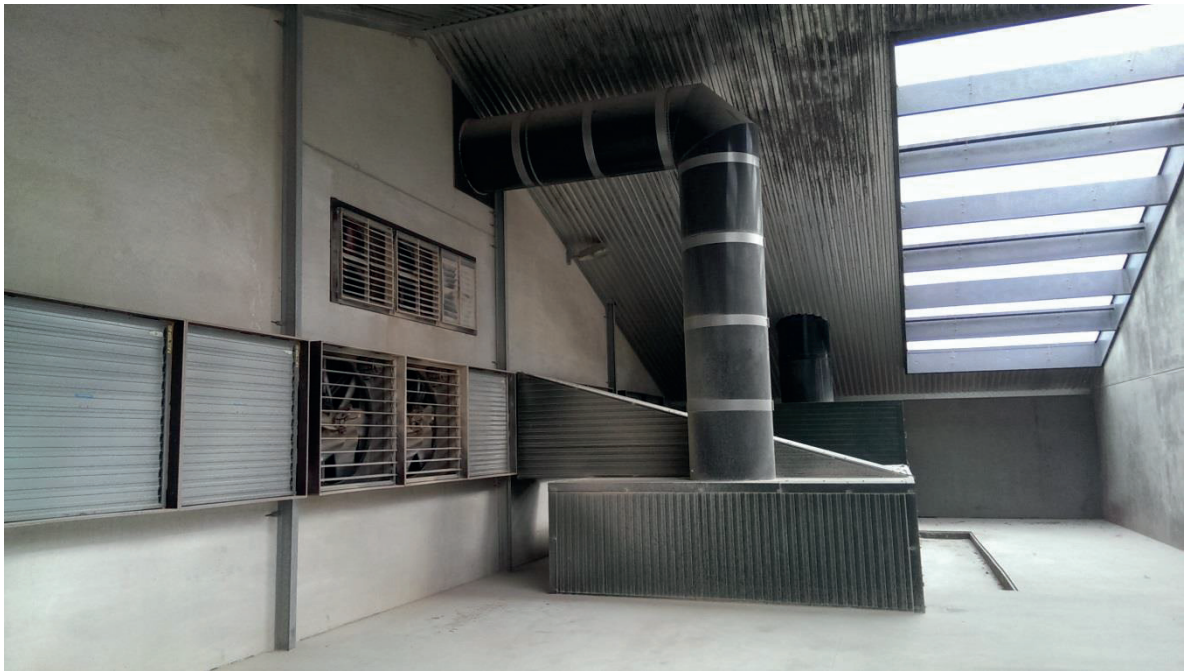
Figuur 8 Ruimte met warmtewisselaar en uitstroomopeningen in het dak in apart gedeelte van de stallen van bedrijf 8
