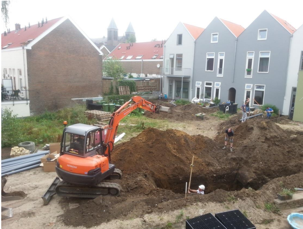
Omdat het hemelwater is afgekoppeld van het rioelstelsel worden infiltratiekanalen geplaatst (Foto: Leendert Douma).
