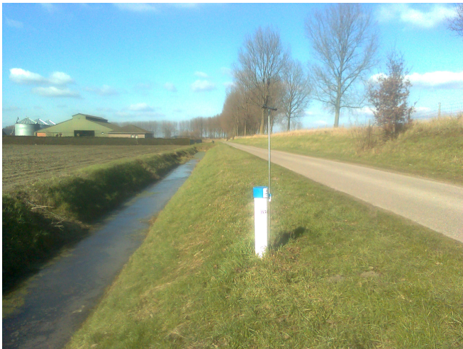
Figuur 3.10 Buis B54F0055 met een slechte ligging in de berm naast een waterloop
