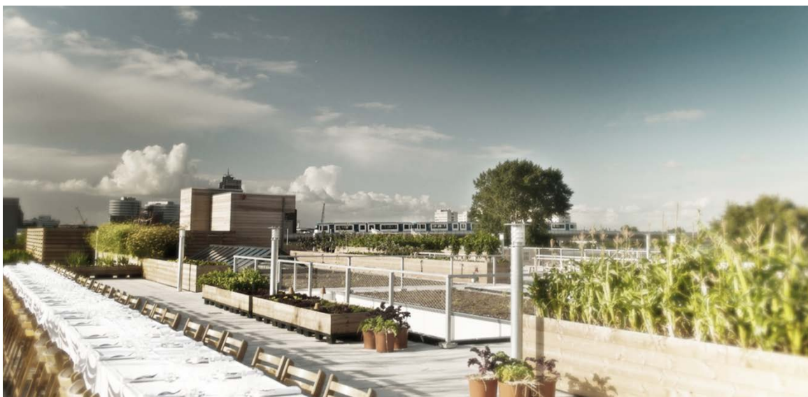
Figuur 2: Op het dak van Kantoor Zuidpark in Amsterdam is een daktuin gerealiseerd
