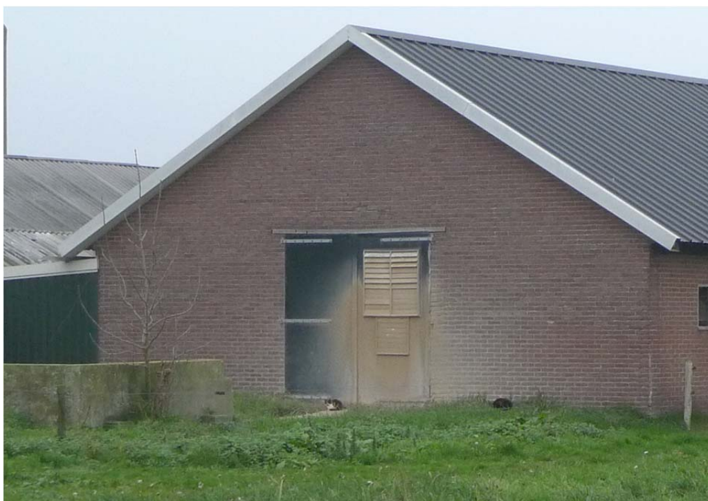
Figuur 3. Een voorbeeld van lengteventilatie bij een kippenstal.
