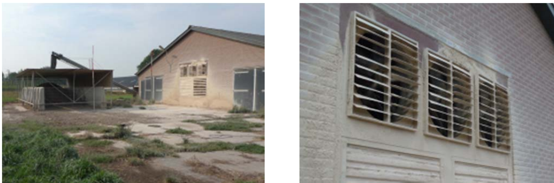
Figuur 4. Overzicht van het betonveld achter de stal en de mestopslag (links) en een detail van de kleine, regelbare ventilatoren die aanstaan (rechts).
