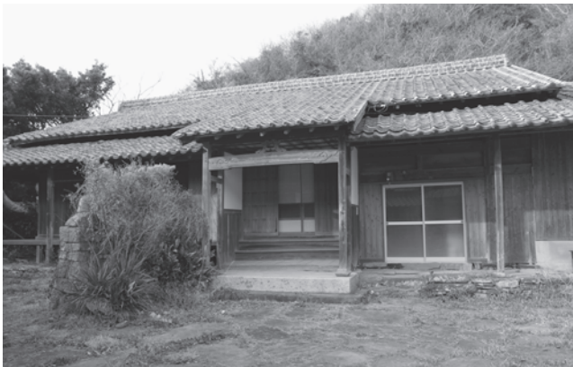
図 17 永留久恵家住宅現状外観 (撮影: 津田, 2011年2月)
