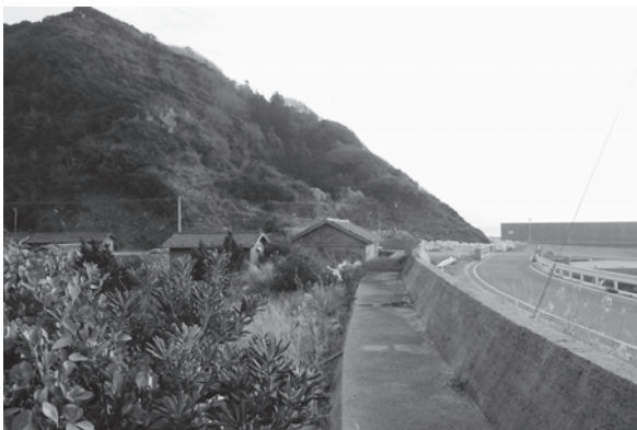
図12 現状写真（撮影：津田，2011年2月），背後の山の形からほぼ同じ位置の写真であることがわかる。コンクリートで造られた防潮堤，その外側に走る木坂港をめぐる道路。
