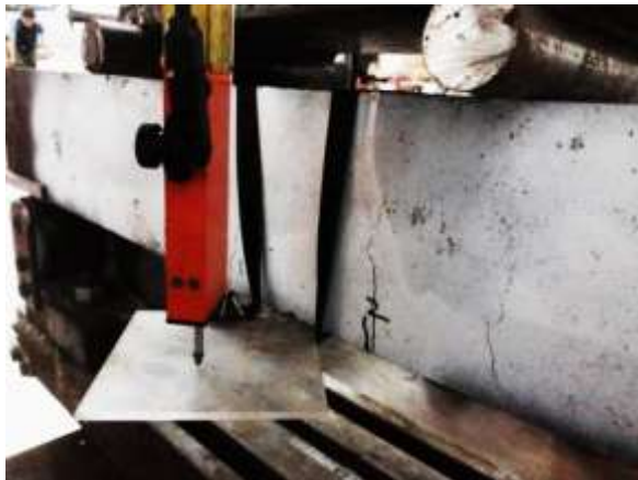
Gambar 4. 9 First Crack pada balok uji 2D10 – 13Apr
