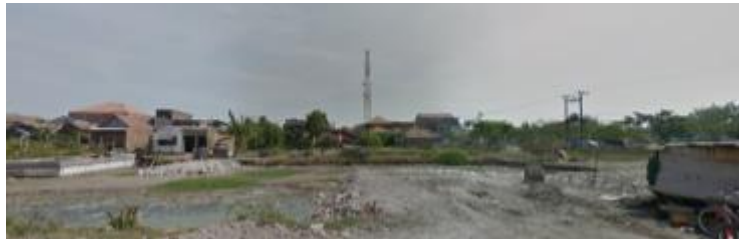
Gambar 2.5 Kondisi eksisting lahan 1
