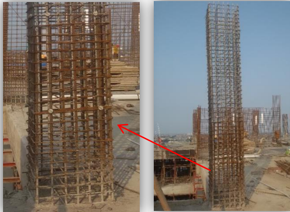
Gambar 4. 92 Hasil Sambungan Tulangan Kolom
