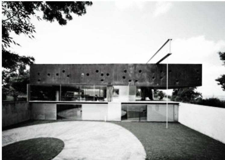
Fig.39 Fachada de la casa de Burdeos mostrando la concepción tripartita.
