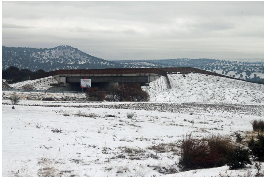
Foto 5. Paso de fauna elevado sobre en uno de los tramos del M-501. Con este tipo de construcciones se minimiza el efecto barrera y la fragmentación del hábitat. Fuente: Minuartia.com
