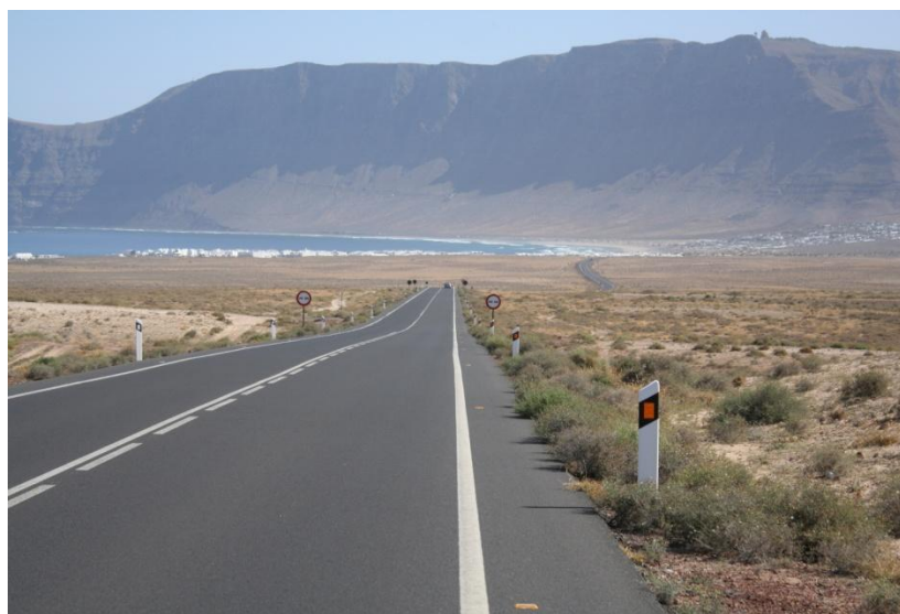
Foto 13. Tramo de la LZ-401 cerca de Famara. La ausencia de señalización que regule la velocidad e indicaciones de presencia de fauna puede ocasionar un exceso de velocidad.
