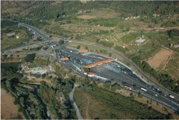
Foto 3.1 El impacto de este tipo de infraestructuras se extiende desde varios decenas de metros hasta varios kilómetros, normalmente van asociadas otro tipo de construcciones humanas como otras carreteras o edificaciones. Imagen del peaje de la autovía M-501. Fuente: Equomadrid.org
