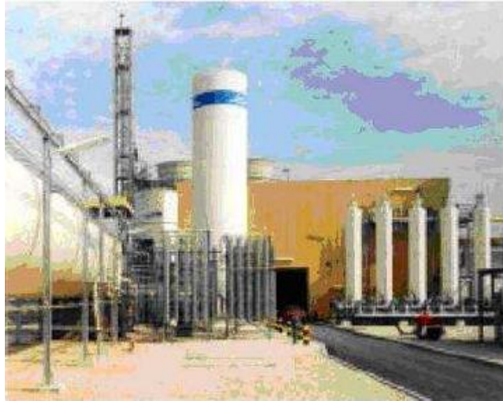
Figura 3.15 Planta de licuación de hidrógeno
