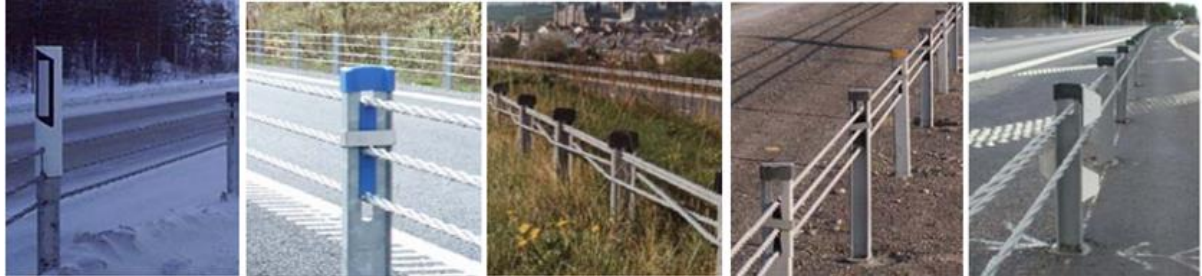
Figur 4. Exempel på Ställineräcke. Typerna som visas är, från vänster: SafeRoad, Safence, Brifen, Cass, Safety Line (Vägverket, u.å)
