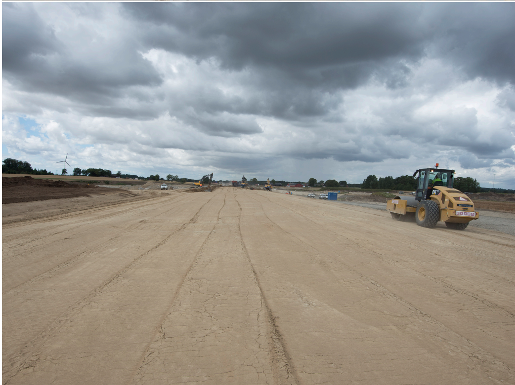
Figur 20 - Övre bilden: Packning av stabiliserat lager med vält. Nedre bilden: Exempel på stabiliserad yta efter packningsarbete. Foton: Per Lindh.
