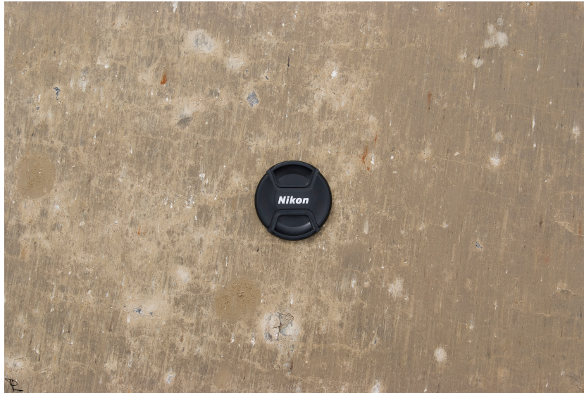
Figur 21 - Exempel på en önskad stabiliserad yta. Foto: Per Lindh.
