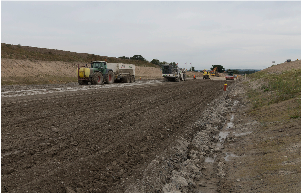
Figur 19 – Vattning, bindemedelsspridning och fräsning på E22 Rolsberga - Fogdarp. Foto: Per Lindh
