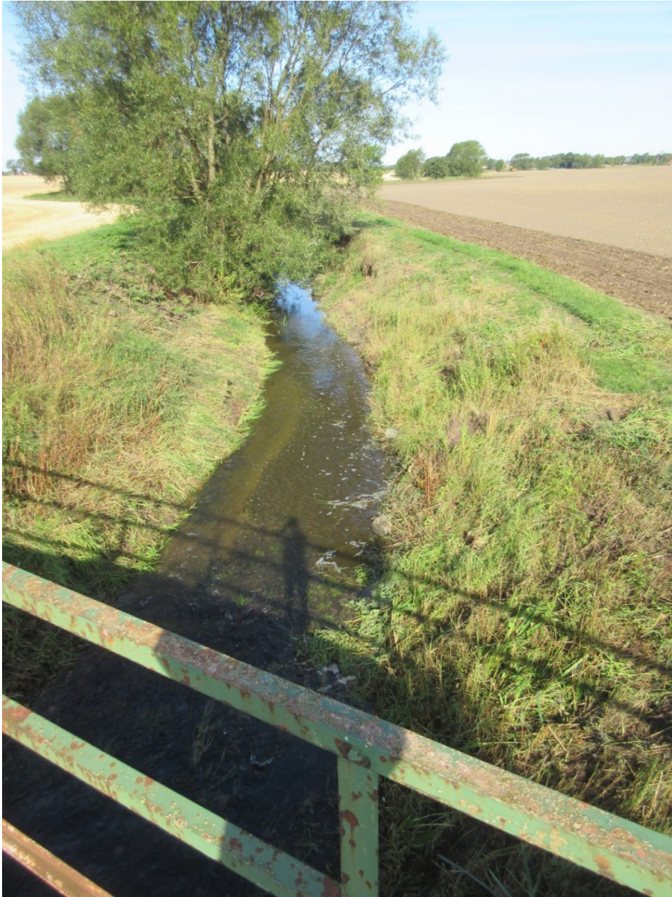
A-3 Sträcka i dikningsföretaget, efter underhåll med klippskopa (Foto: Nina Svenbro)
