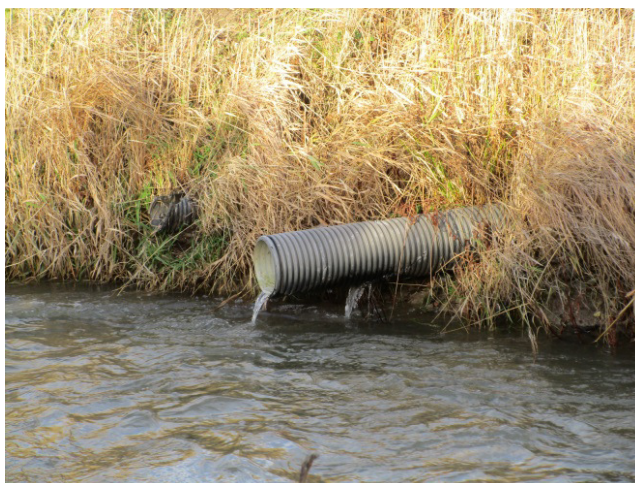
Figur 1-1 Täckdikningsutlopp till Höje ås huvudfåra (Foto: Nina Svenbro)
