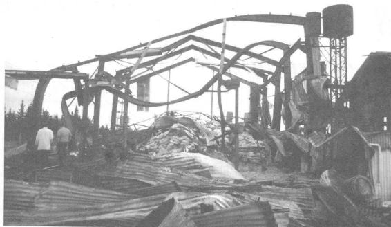
Figur 2.5: Exempel på en stålbrand för oskyddat stål [3]
