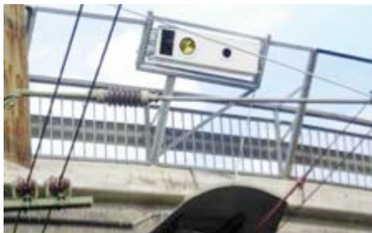
Figur 14: KIKA-detektor på bro (Foto: Trafikverket)
