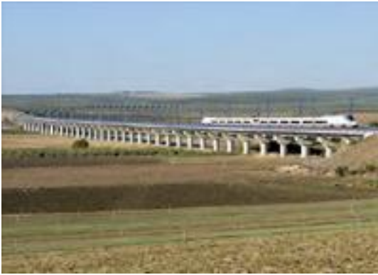
Figur 4: Viaducto Arroyo del Salado (Acciona, 2012).
