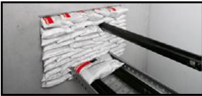
Bild nr 5. Exempel på användning av brandskyddskuddar (Hilti, 2, 2010).
