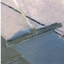
Figur 28: Tätning av sprickor med impregnering (Basham, 2006).
