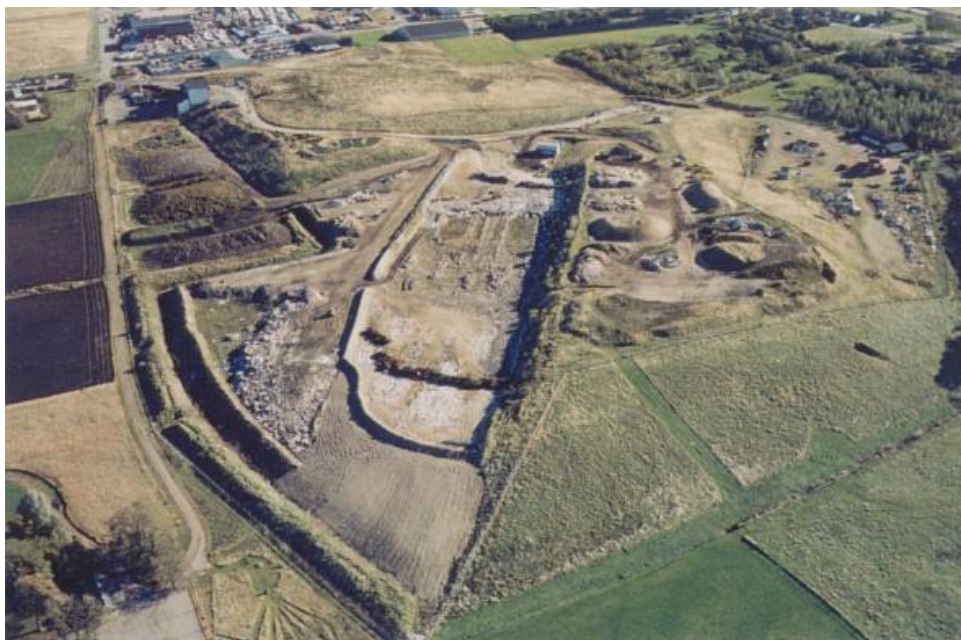
Figur 13. Foto över SYSAVs deponi Albäck, Trelleborg. I förgrunden syns de deponeringsceller som var aktiva vid tiden för fotot, 1997. På höjden syns de lagringsytor som används och överst till vänster i bilden syns kompostytorna och dammsystemet. (SYSAVa, 1997)
