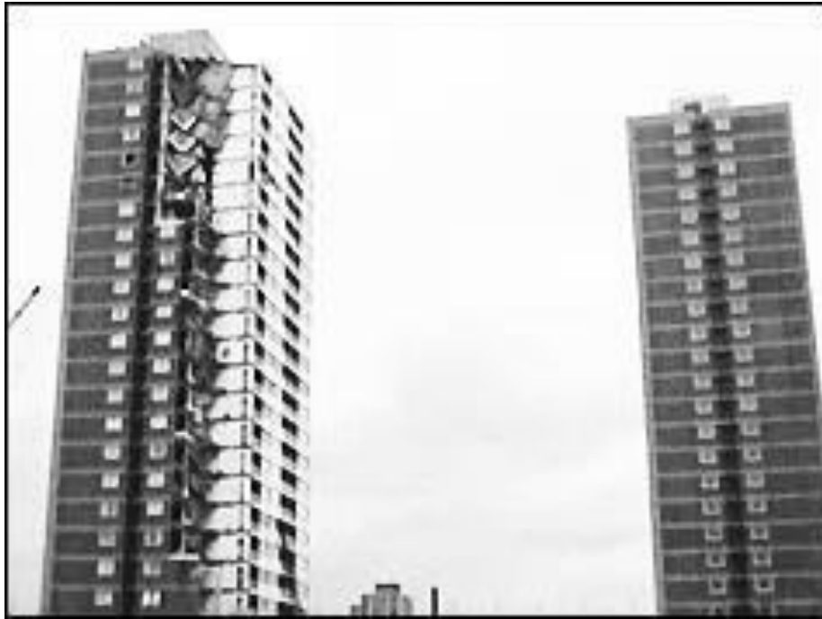
Figur 3.2 : Raset i Ronan Point, London 1968, där flera våningar förstördes. Huset till vänster visar de förstörda bostäderna.
