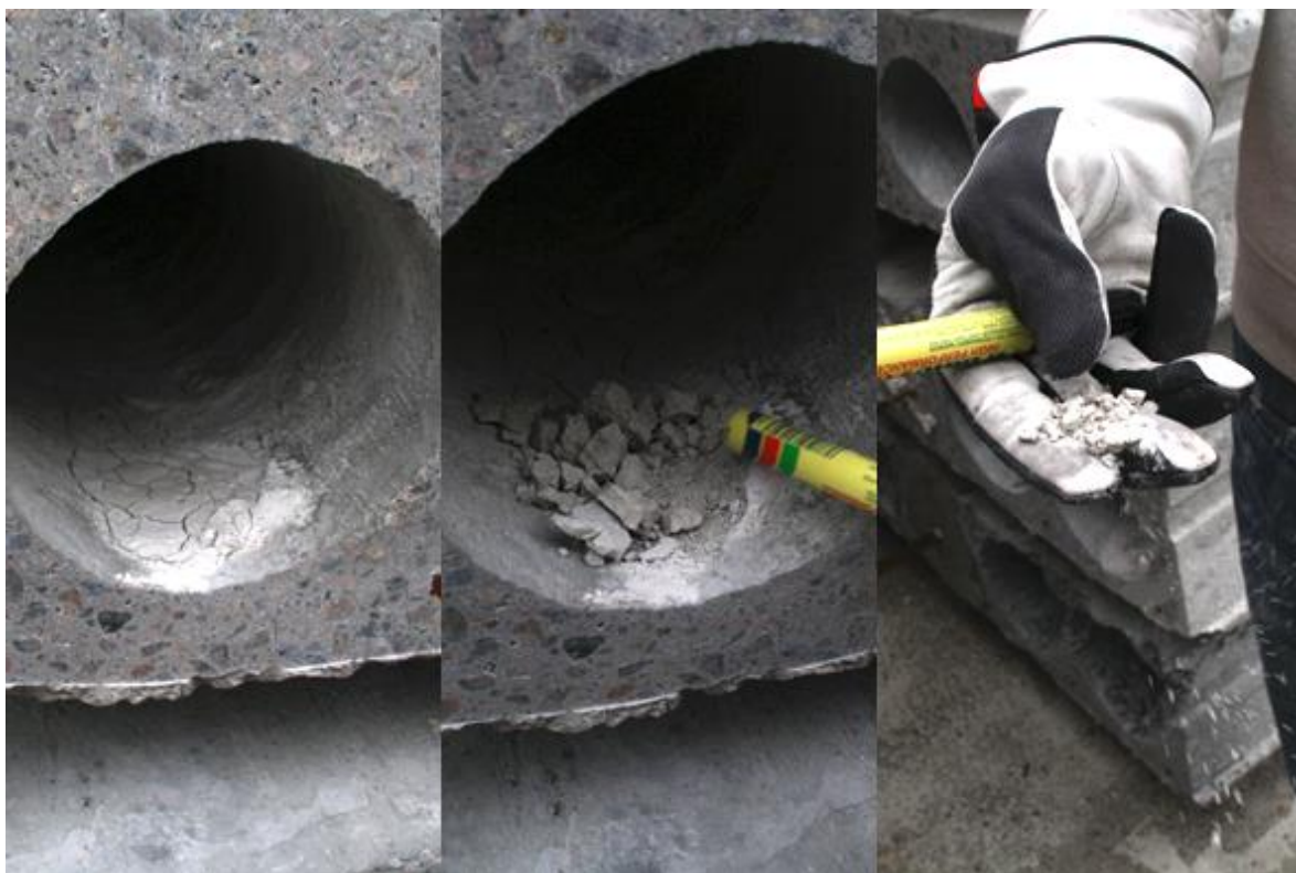
Figur 4.1: Närvaro av cementhinna i HD/F-kanal.
