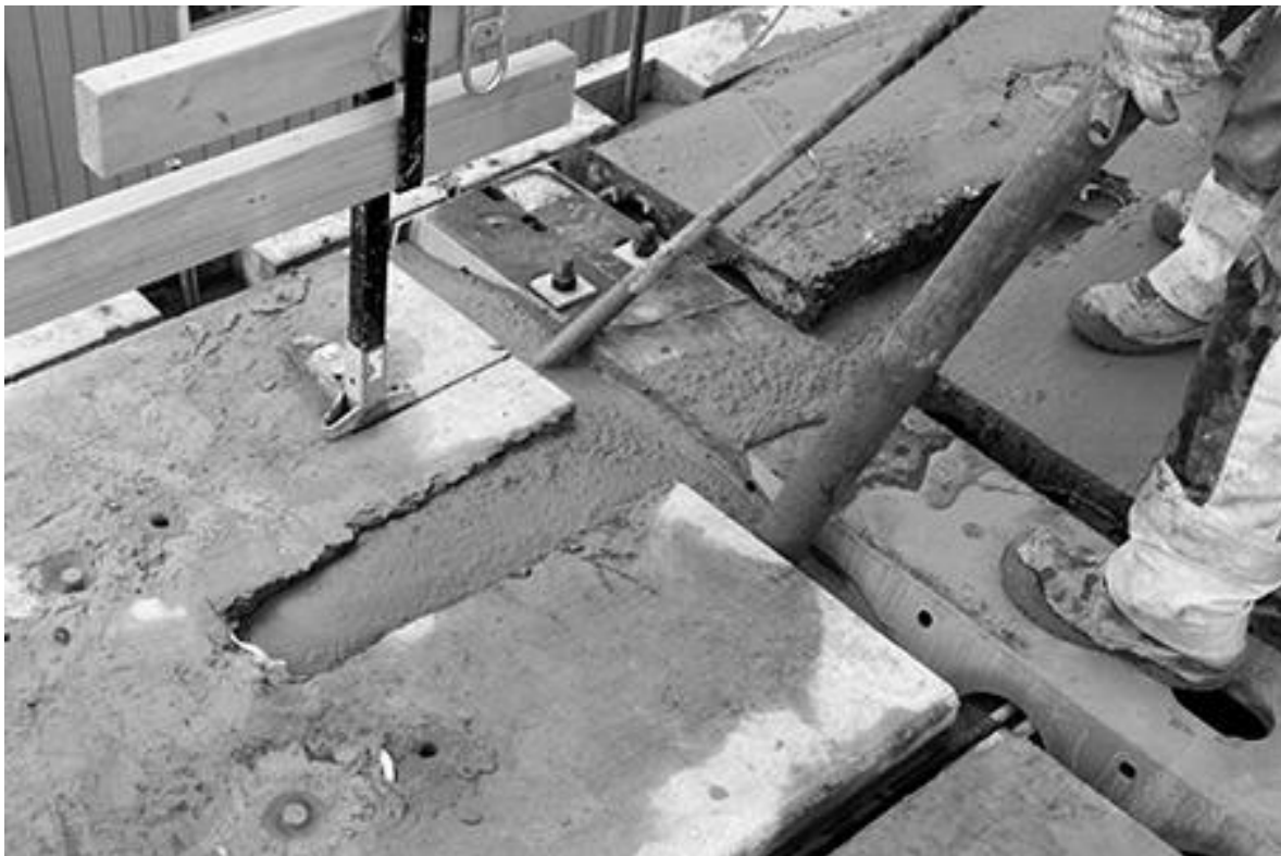
Figur 2.8: Igjutning och vibrering av betong för anslutning till hattbalk.
