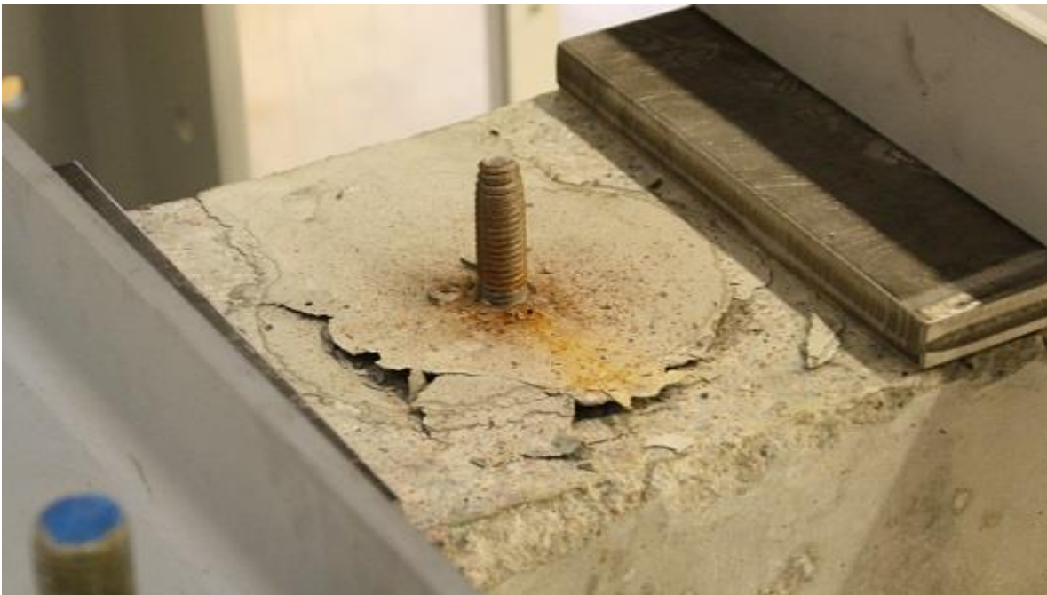
Figur 5.20: Sprickor i igjutningen i prov D3.
