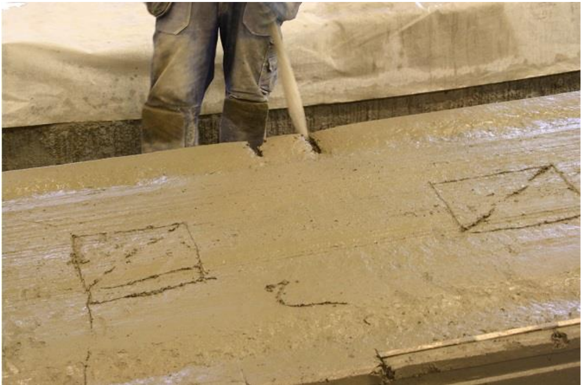
Figur 2.3: Uppmätning och upphackning av ursparningar.
