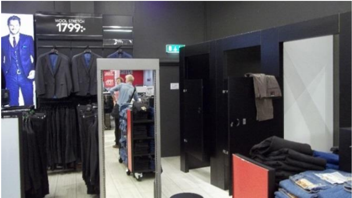
Figur 10. Otydlig utrymningsdörr och utrymningsskylt på Dressmann.
