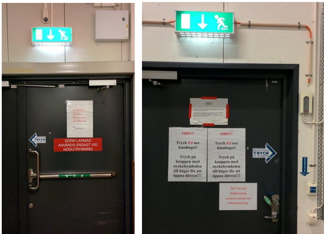
Figur 6. Exempel på två utformningar av nödutrymningsdörrar på Familia.
