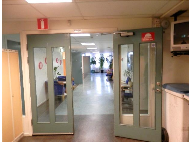
Figur 30. En av korridorerna på Sprint-gymnasiet där några av sopkärlen står.
