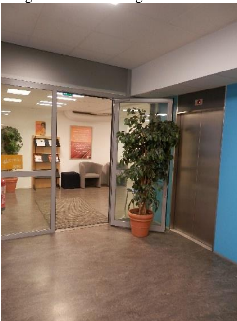
Figur 49. Dörren som är uppställd med en krukväxt vilket resulterar i brandgasspridning i huvudtrapphuset.
