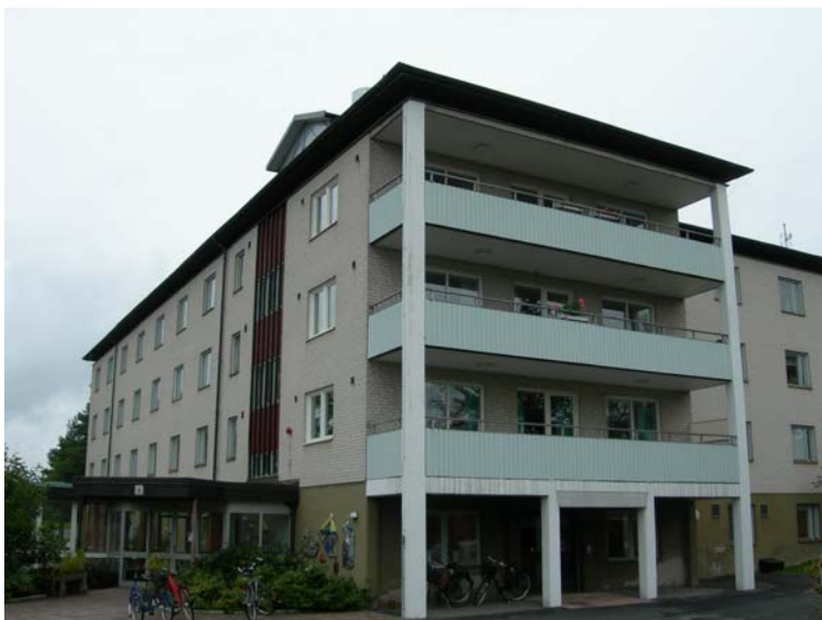
Figur 4-20 Bild på byggnad A.
