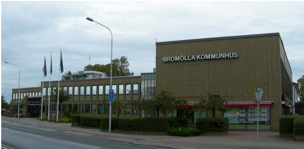
Figur 4-15 Bild på Bromölla Kommunhus, visar den västra fasaden.
