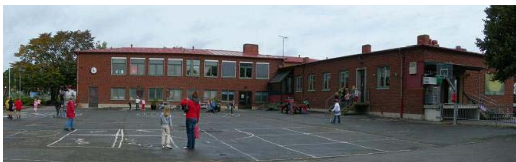
Figur 4-12 Bild på byggnad B, tagen från gårdssidan
