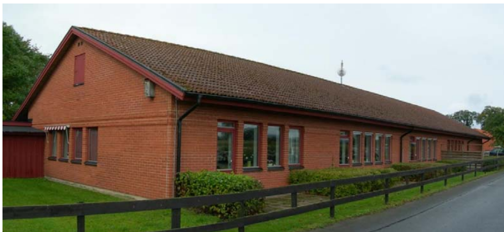
Figur 4-11 Bild på byggnad A.
