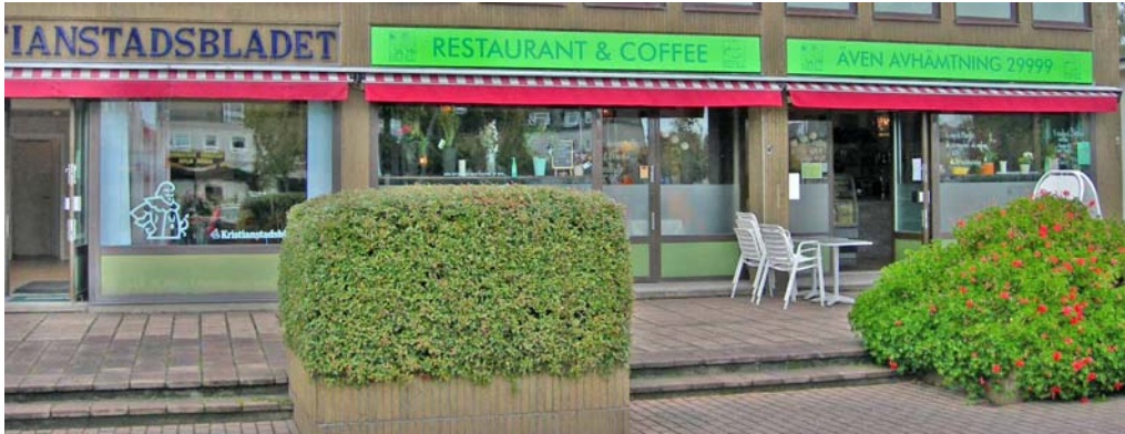
Figur 4-16 Bild på Kommunhusets södra gavel, visar öppna ytterdörrar till restaurang och kontorslokal.
