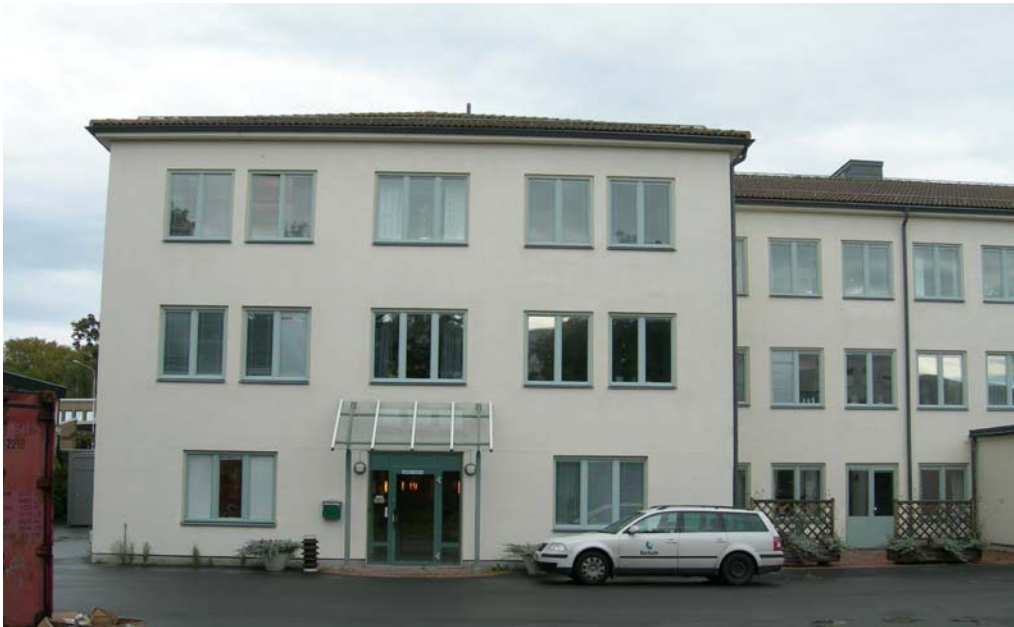
Figur 4-18 Bild på byggnad A, bilden är tagen från baksidan.
