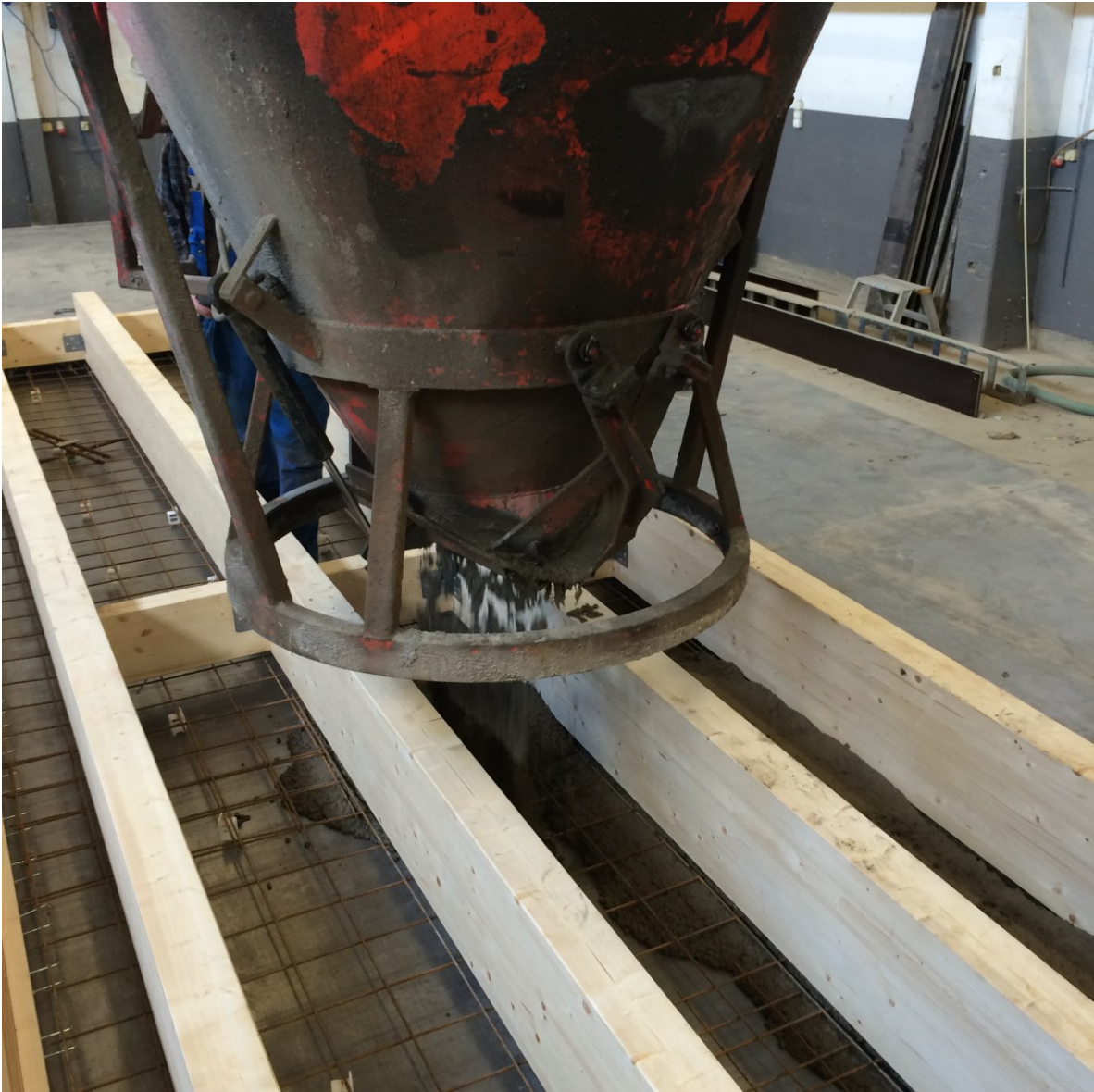
Figur 3.4: Gjutning av betongplattan.
