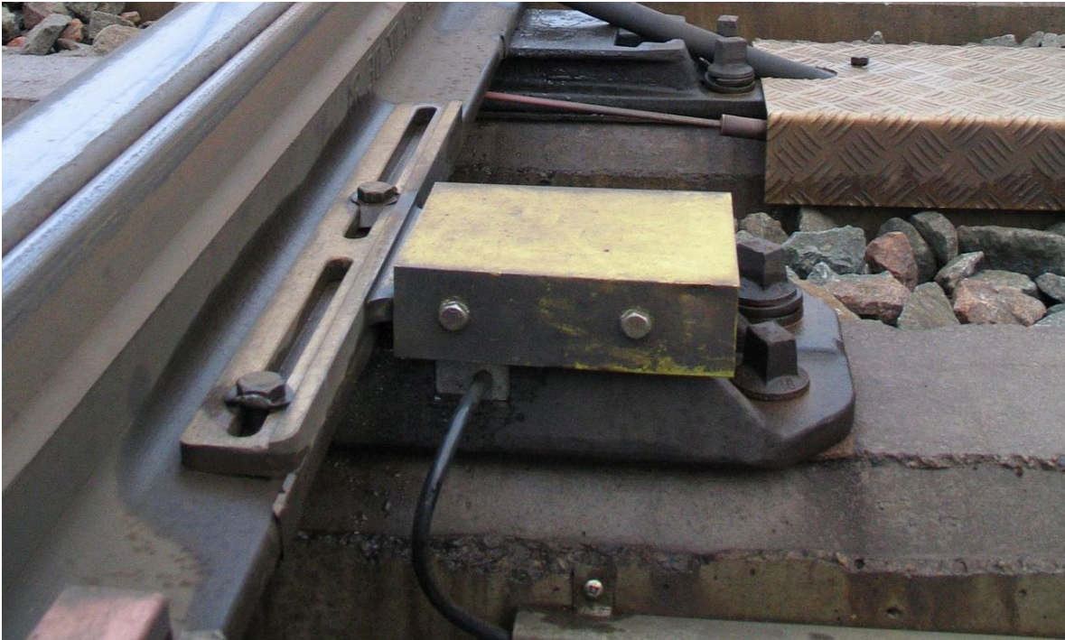
Figur 4 Växel med TKK. Källa: (Banverket A, 2005)
