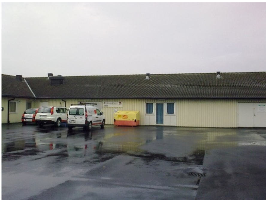
Bild 7. Östlig fasad, plåt
