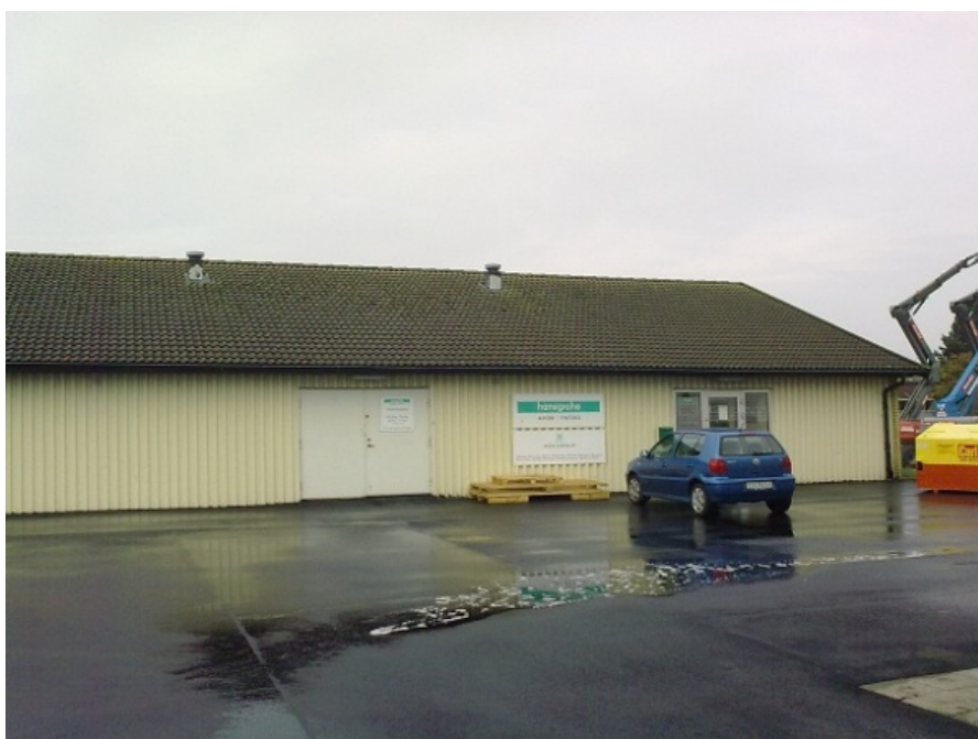
Bild 8. Östlig fasad, plåt
