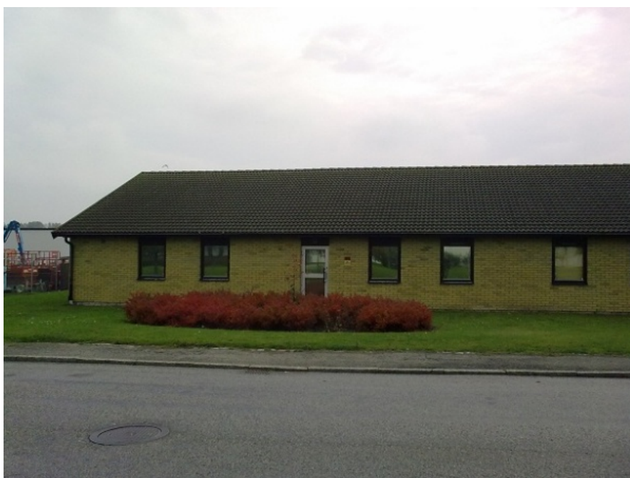
Bild 10. Västlig fasad, tegel
