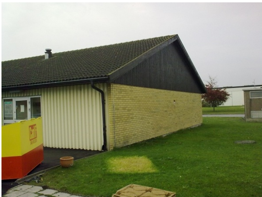
Bild 9. Nordlig fasad, tegel
