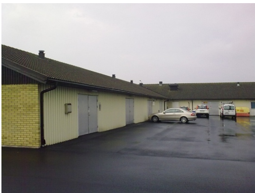
Bild 6. Nordlig fasad, plåt
