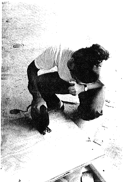
Figur 7.7 Utsågning av plywood
